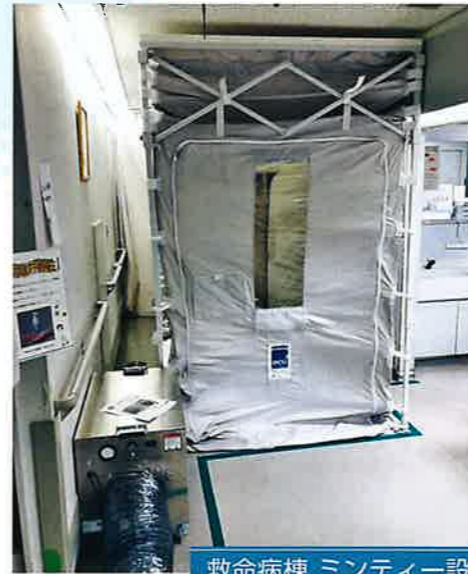
救命病棟 ミンティールーム設置 (空気感染隔離ユニット)
